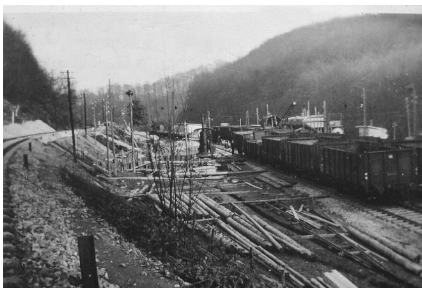
Das gesamte Material für den Bau der Angertalbrücke wurde über die Kalkbahn herangeschafft. Bei der Gaststätte Müschenau wurde zu diesem Zweck eine Gleisharfe für viele Güterwaggons angelegt. (Heute befindet sich dort ein Campingplatz)
