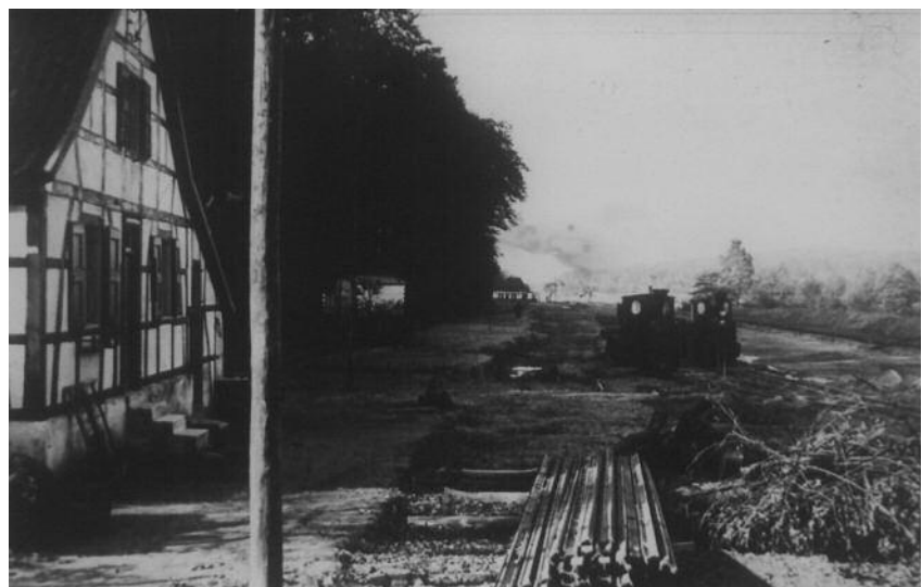
Beginn der Erdarbeiten im Bereich der heutigen Brücke, auf der die Kreisstraße von Hösel nach Eggerscheidt die Autobahn überquert. Die Aufnahme entstand im Herbst 1935. Links der Kothen „Am Kämpchen“, im Hintergrund das Haus „Neuallscheidt“
