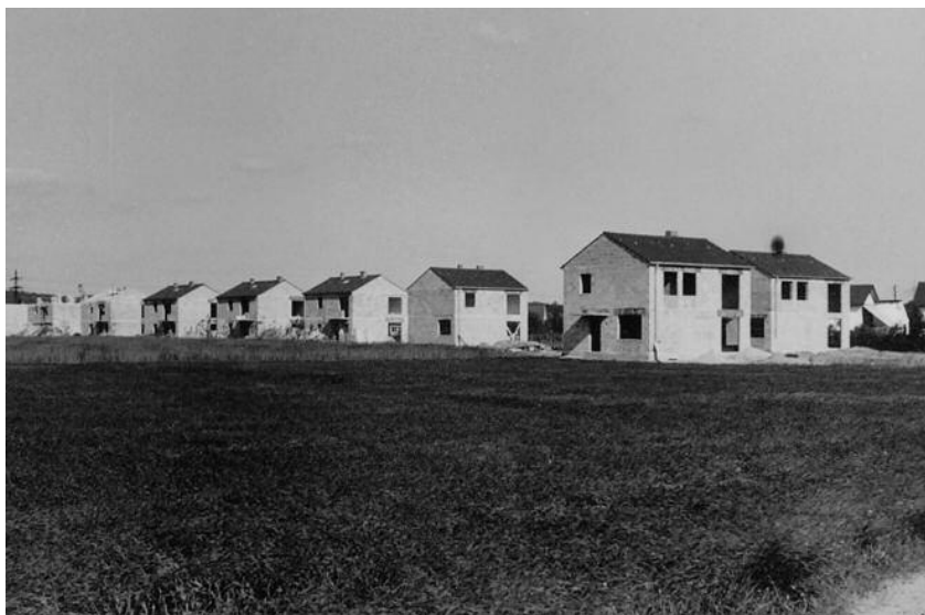
Die Siedlung von der Kalkstraße aus gesehen
