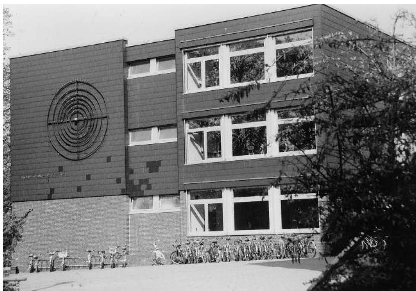
Der 3. Bauabschnitt des Kopernikus-Gymnasiums mit dem Modell des kopernikanischen Weltbildes. Jetzt ist in diesem Gebäude die Heinrich-Schmitz-Grundschule untergebracht
