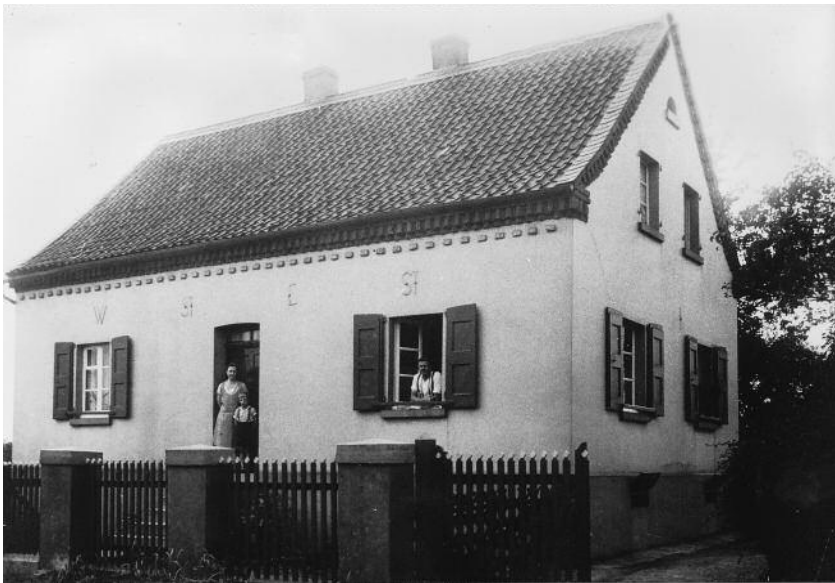
Das Haus von Schneidermeister Fritz Mentzen an der Speestraße. Er war von 1938 bis 1950 Erster Brandmeister der Lintorfer Feuerwehr und außerdem Amtsbrandmeister des Amtes Ratingen-Land (später Angerland). Das Haus wurde um 1836 von Adolph Wilhelm Steingen (W.St), dem Gründer der Bäckerei Steingen an der Speestraße, und seiner Frau Elisabeth, geborene Pohlmann (E.St) errichtet. Heute steht an seiner Stelle ein Neubau mit den Geschäften Salon Degen und Sport Weber und Tischler
