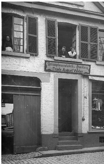
Das Haus Düsseldorf Straße 14 um die Jahrhundertwende. Am Fenster links Friederike Weber, rechts ihre Kinder Hugo und Hedwig. Links unten erkennt man die überbaute Toreinfahrt
