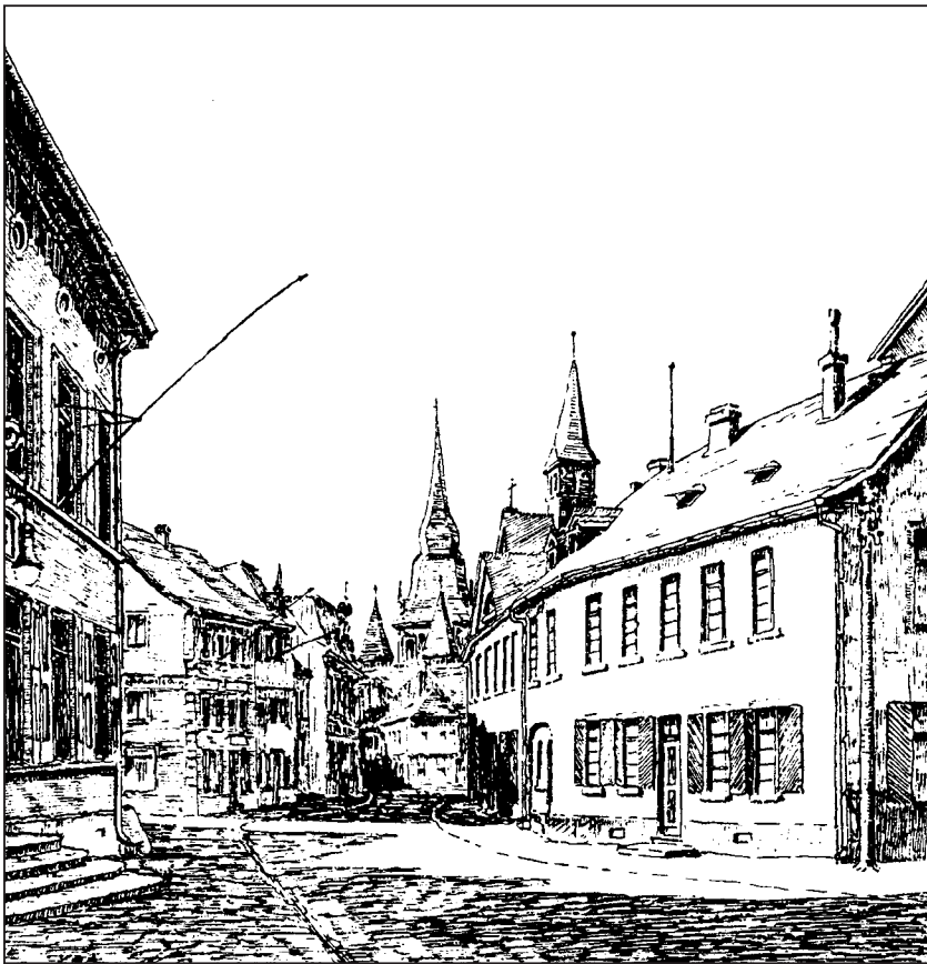
Das „Gasthaus zum Heiligen Geist“ und spätere Marienkrankenhaus an der Ecke Oberstraße/Angerstraße vor 1904 Zeichnung von Ernst Bierwirth, Ratingen, 1926
