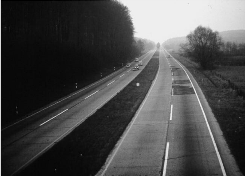
Die Autobahn in Fahrtrichtung Krummenweg in den 50er Jahren. Rechts befindet sich heute die Raststätte Hösel. Noch ist wenig Verkehr auf der Autobahn, und die Fahrbahn ist nur notdürftig ausgebessert. Leitplanken gibt es noch nicht
