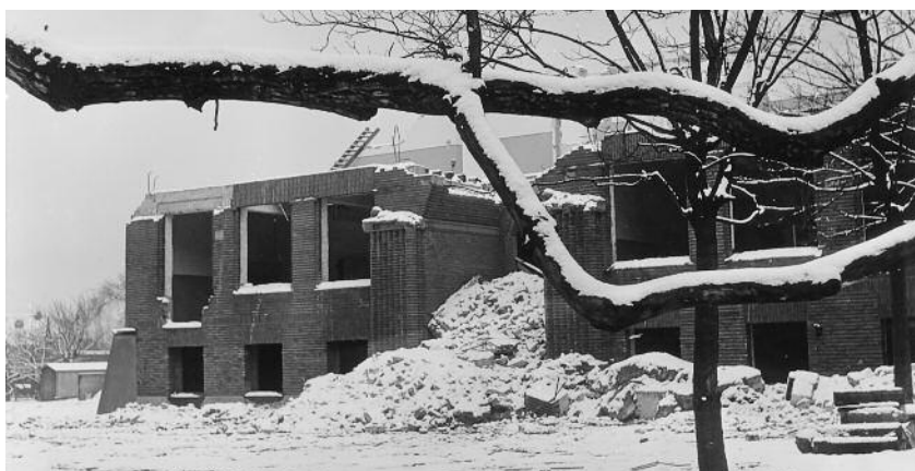
Abbruch der alten Johann-Peter-Melchior-Schule. Winter 1955/56
